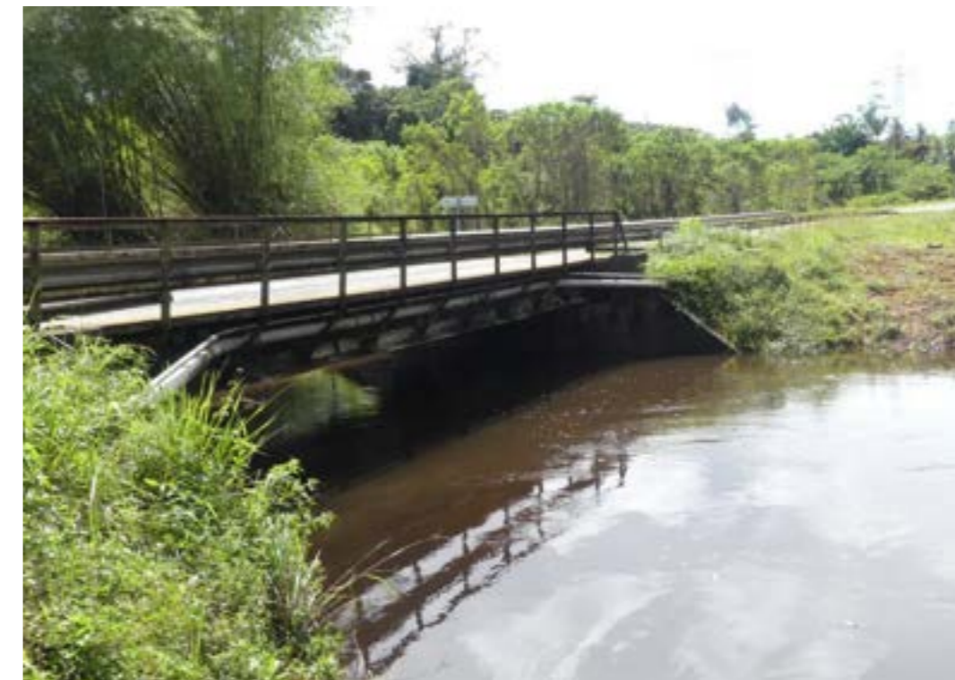
Figure 4 : Ouvrage d'art actuel
