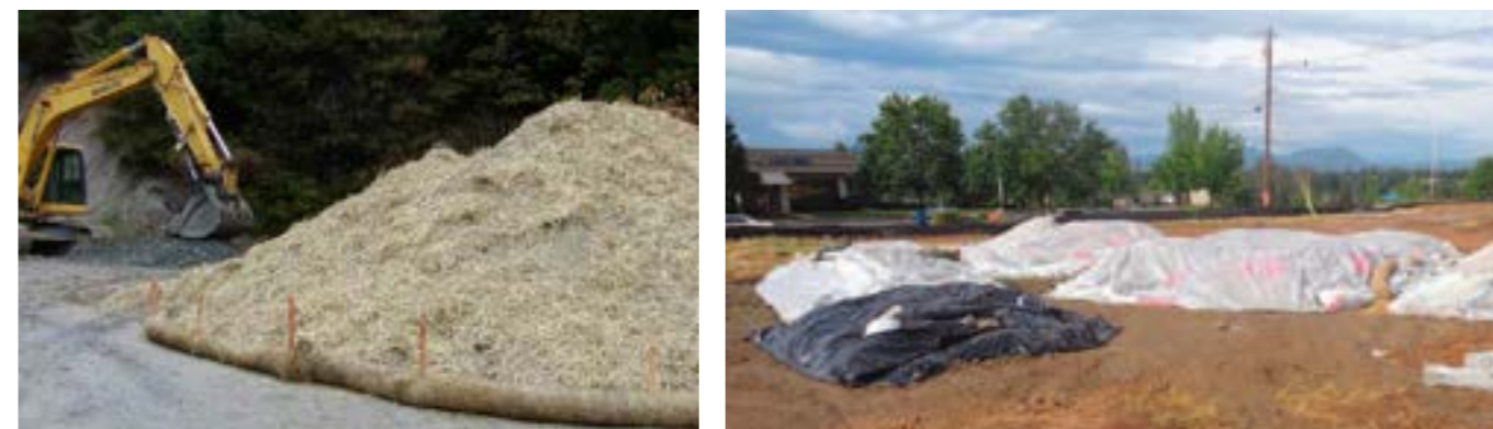
Figure 62 : Exemples de protection des dépôts provisoires à l'aide de paillage par mulch (à gauche) et de géomembranes (à droite) [Guide des bonnes pratiques environnementales – Protection des milieux aquatiques en phase chantier, AFB, 2018]
