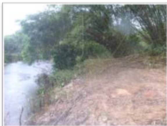
Station à l'aval du pont vue Rive droite
