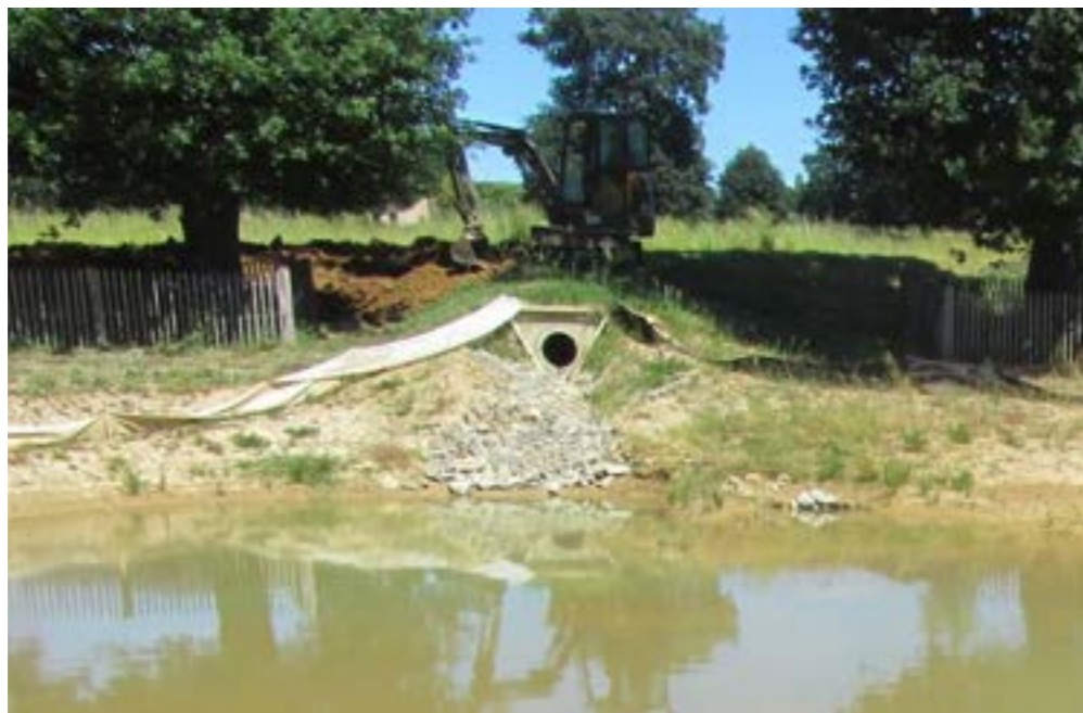
Figure 61 : Exemple d'empierrement avant exutoire [ARTELIA]
