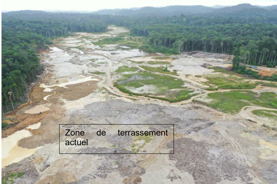
Figure 3 : Vue 06/2020 vers l'Ouest AEX3 et 1TOG
