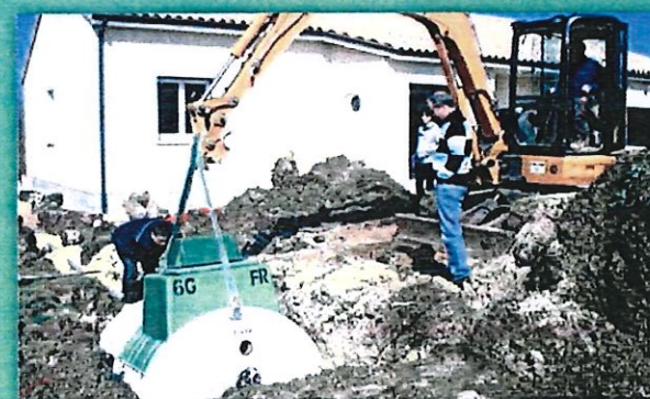
Installation d'une Tricel Novo FR5
