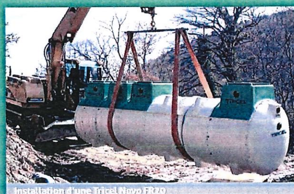
Installation d'une Tricel Novo FR20
