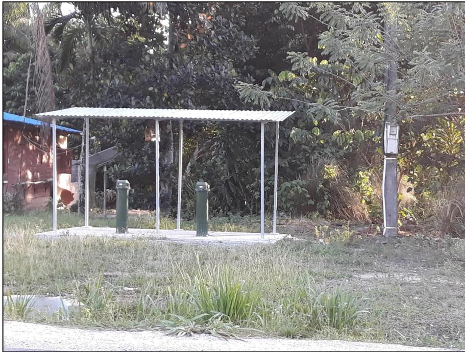
*Figure 26 : Un des couples de bornes-fontaines mis en œuvre lors de la tranche 1*
