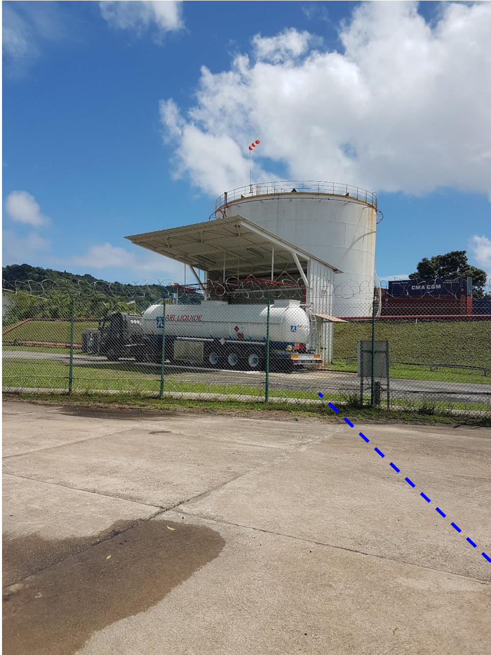
Figure 6 : zone de raccordement nord prévue (crédit photo : EURETEQ, le 26/10/2021)
