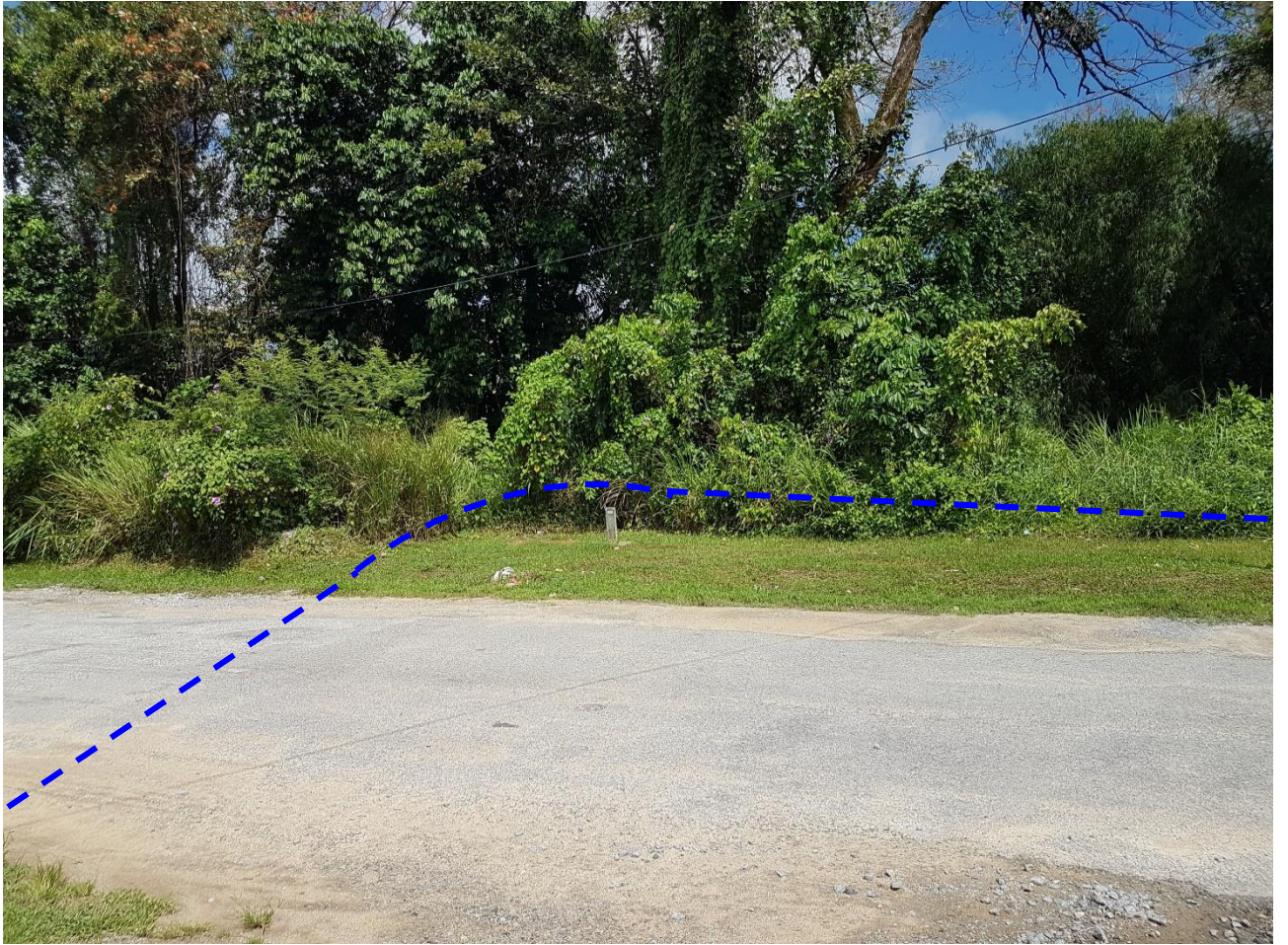
Figure 4 : traversée de la route d'accès à la marina (crédit photo : EURETEQ le 26/10/2021)
