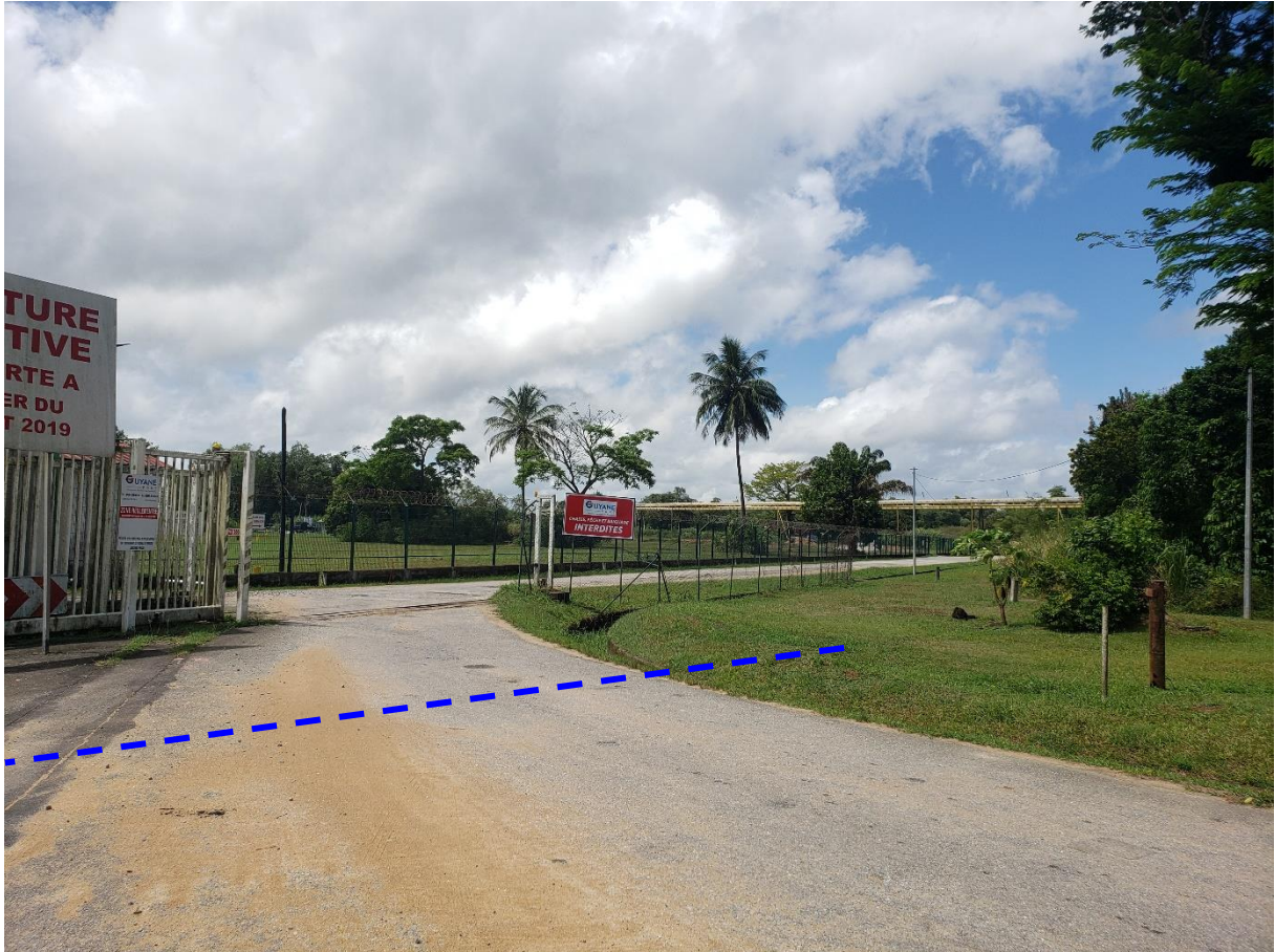
Figure 7 : traversée de la route d'accès à la marina (crédit photo : EURETEQ, le 26/10/2021)
