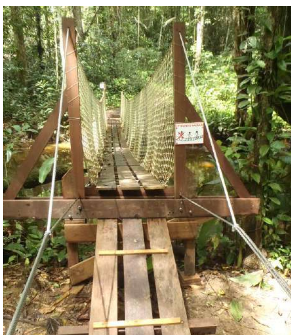
Photo 13 : Aménagement d'un pont de singe sur un sentier pédestre – Saül (© ONF)
