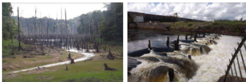
Planche photos : Arbres morts dans la retenue de Petit Saut et seuil aérateur en aval de la centrale hydroélectrique (crédit photo M. Chanseau)
