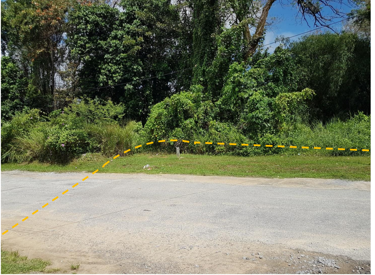
Figure 4 : traversée de la route d'accès à la marina (crédit photo : EURETEQ le 26/10/2021)
